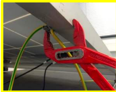
Aard de zonnepanelen middels de aardingsclips.
