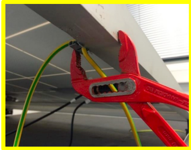
Aard de zonnepanelen middels de aardingsclips.
